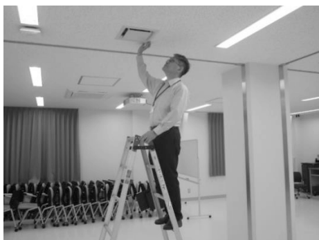
天井排気口の確認
